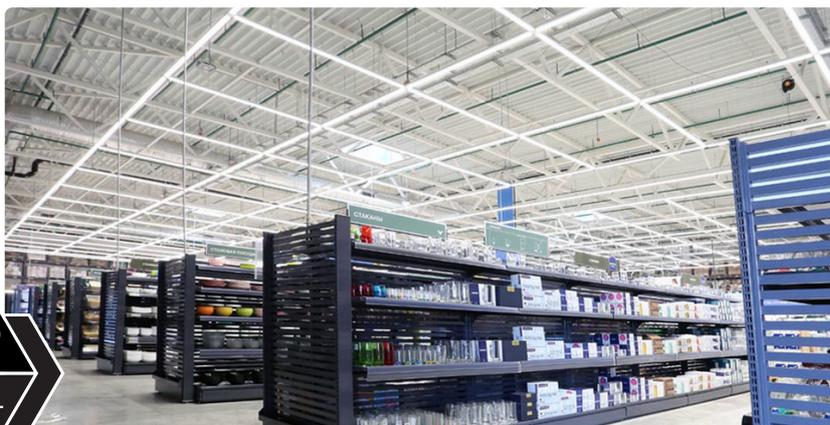
Светодиодные пылевлагозащищенные светильники Navigator серии DSO-01-LED (аналог ЛСО) предназначены для освещения торговых пространств и коммерческих помещений. Внутри светильников реализована сквозная проводка, соединительная крышка позволяет подключать светильники в герметичную линию без видимых проводов.
